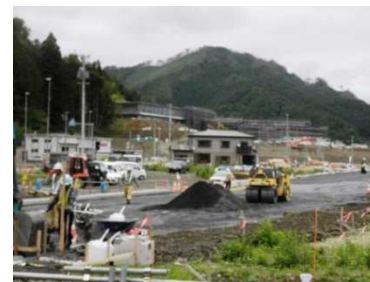
いたる所で進められる道路工事
