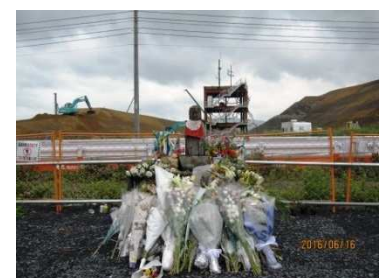
南三陸町防災対策庁舎と かさ上げの盛土
