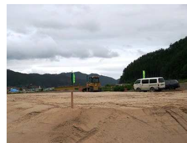
鶴住居の嵩上げ現場
