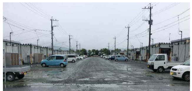
熊本地震被害のあった益城町の仮設住宅
