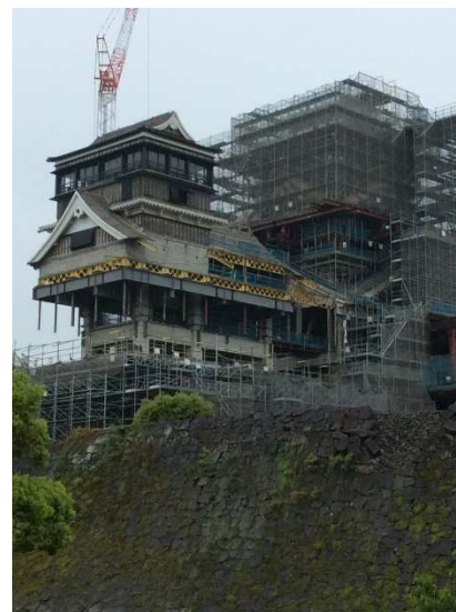
修復工事が進む熊本城
